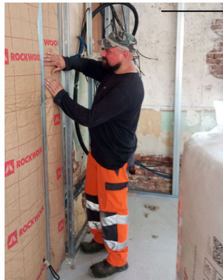
Jérémie pose du placo dans l'ancien appartement des instituteurs, qui deviendra le local technique des agents
